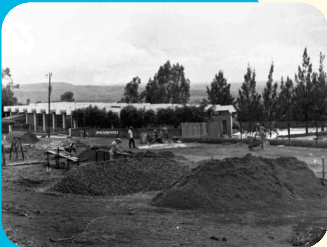
Início da Obra: Geraldo Aguiar Cambraia, 1960.
